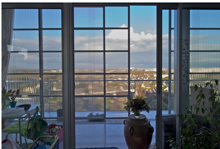
▲ Dans le quartier du Grand Parc, à Bordeaux (photo du haut), du patrimoine d'Aquitainis, comme dans la tour Plein Ciel, résidence de Silène, les logements réhabilités par Lacaton & Vassal offrent désormais de généreuses ouvertures.
